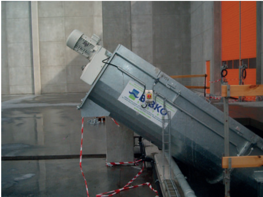
Устройство выгрузки RWS (во время монтажа)
